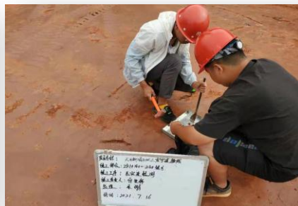
填方压实度检测
