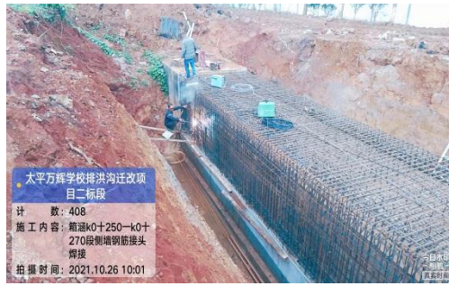
侧墙钢筋焊接
