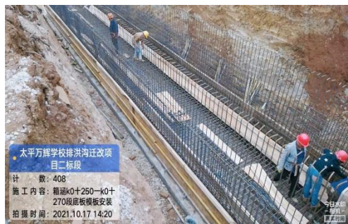
k0+250~k0+270 段底板模板安装
